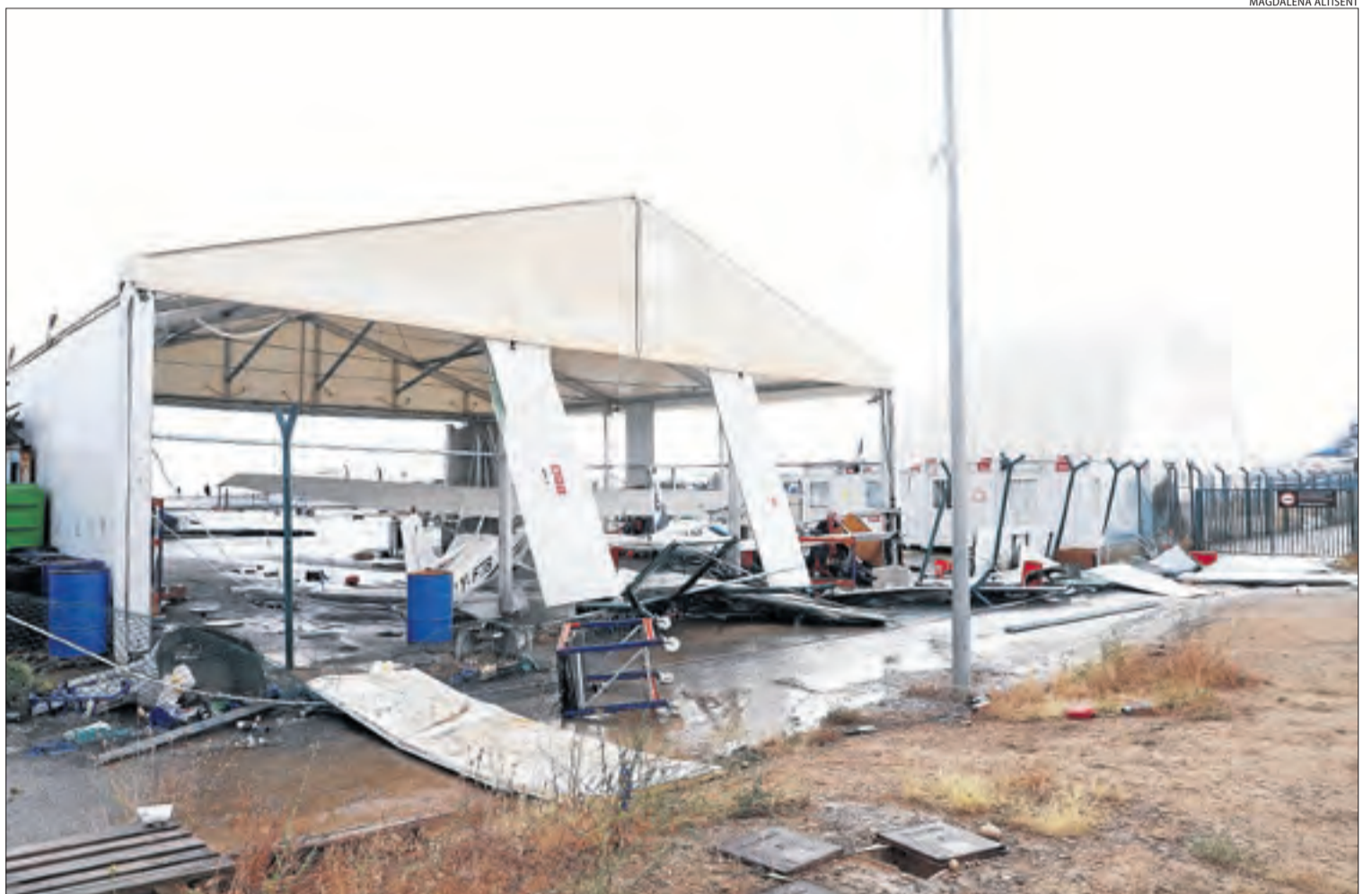
El vent va fuetejar l'aeroport d'Alguaire, va arrancar mòduls prefabricats i fins i tot va destrossar part d'un hangar inflable.
